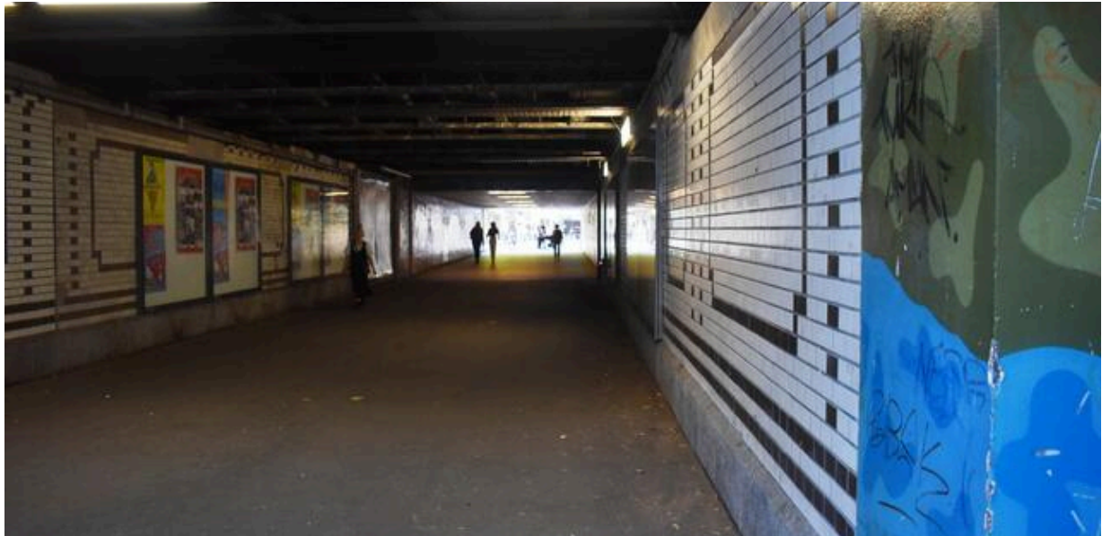
Der Tunnel unterquert die Autobahn und S-Bahn-Trasse. • Foto: Schilp • hochgeladen von Susanne Schilp
